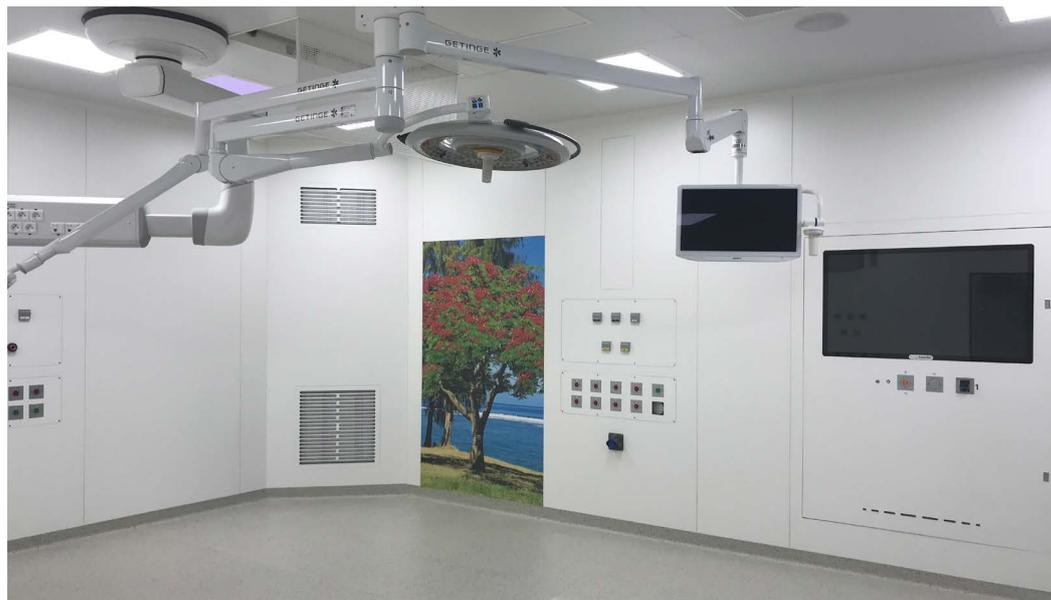
Ces modules sont entièrement prééquipés et précâblés en usine, ce qui garantit un gain de temps, une diminution des risques chantier ainsi qu'une qualité de finition optimale. Ils sont également démontables pour assurer une évolutivité et une maintenance aisées.
